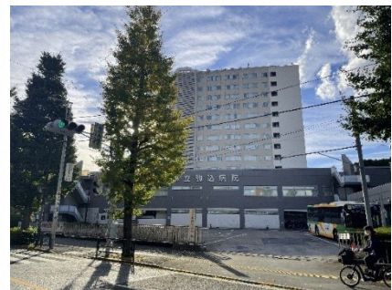
東京都立駒込病院
