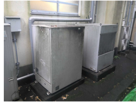
既存空調室外機状況
