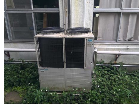
既存空調室外機状況
