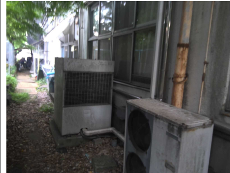
既存空調室外機状況
