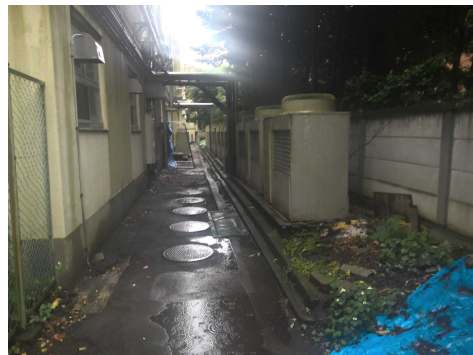
既存空調室外機状況
