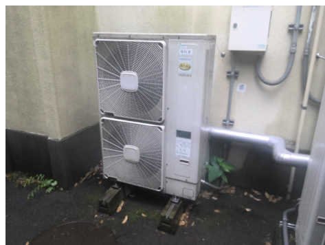
既存空調室外機状況
