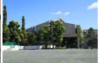
文京スポーツセンター
