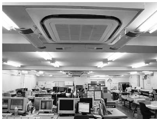
省エネタイプのエアコン5台を設置した3Fフロアの様子。
