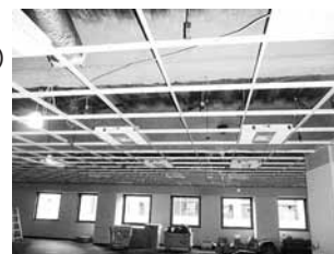
改修中の天井 (グリット工法)
