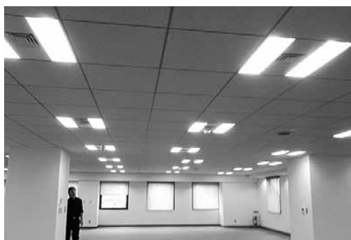
施工後の天井は、点検口が不要、照明・空調の移設や増設が自由に行える。
