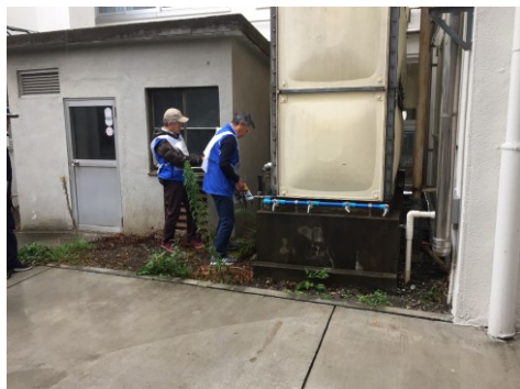
受水槽の確認
