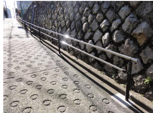
急な坂道への手すりの設置
