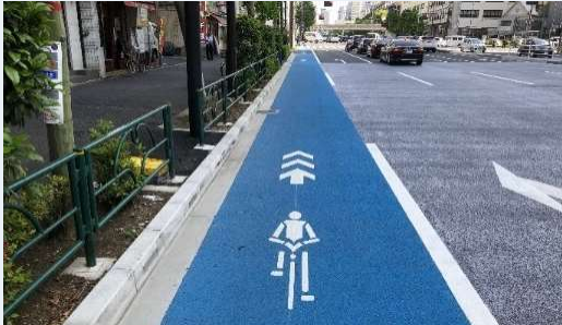
自転車専用通行帯（白山通り）
