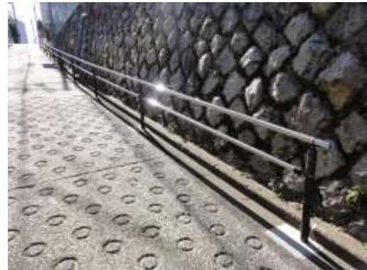
急な坂道への手すりの設置
