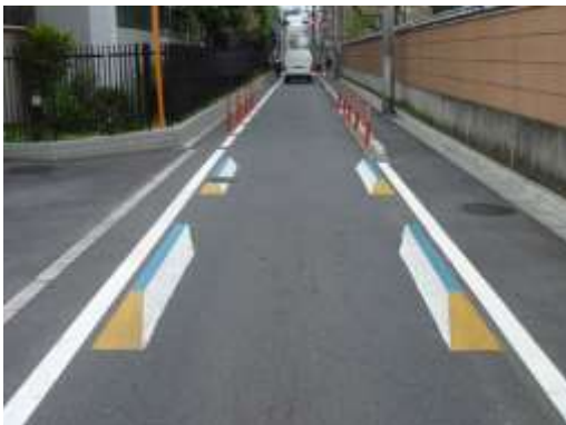
コミュニティ道路（歩道なし：路面表示）
