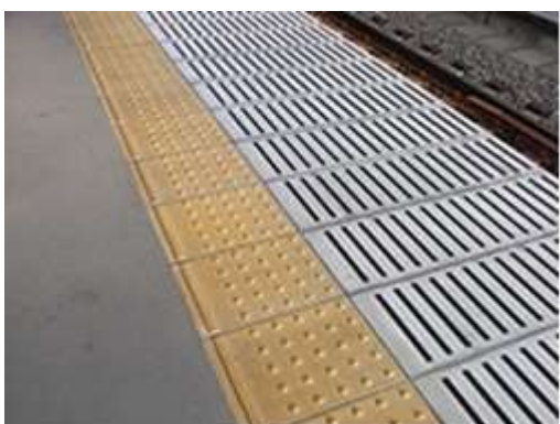
内方線付点状ブロック
