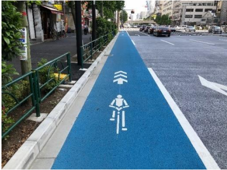
自転車専用通行帯（白山通り）
