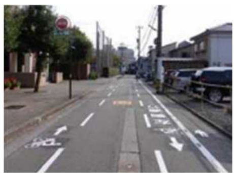
出典：金沢市自転車活用推進計画 自転車通行位置の明示 （金沢市）
