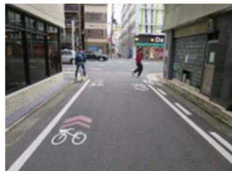
出典：第4回 京都市自転車走行環境整備ガイドライン部会 協議資料 自転車通行位置の明示 （京都市）
