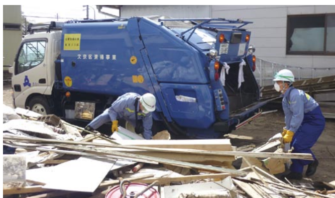
●作業の様子。右の写真は津波等で地面が不安定なため、使用できなくなった畳を敷いて通路を確保している。
