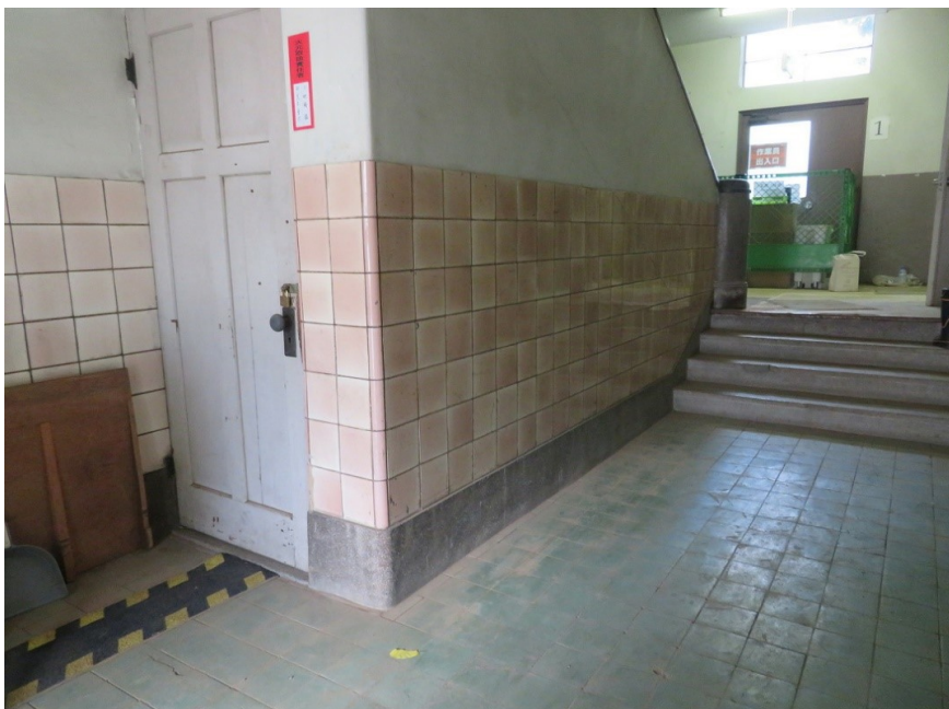
07-02-南東第1階段1階通路と 倉庫
