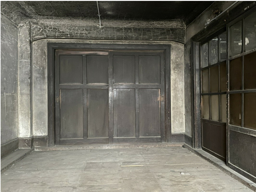
34-01-地階北棟旧小使室 入口と押入の扉
