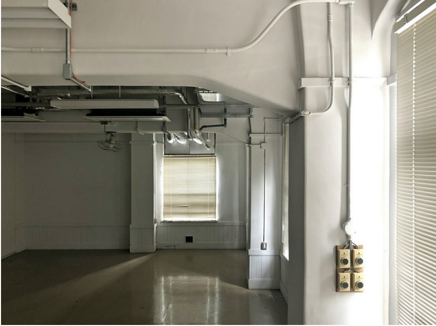
25-01-3F西棟旧図画教室 窓枠腰壁
