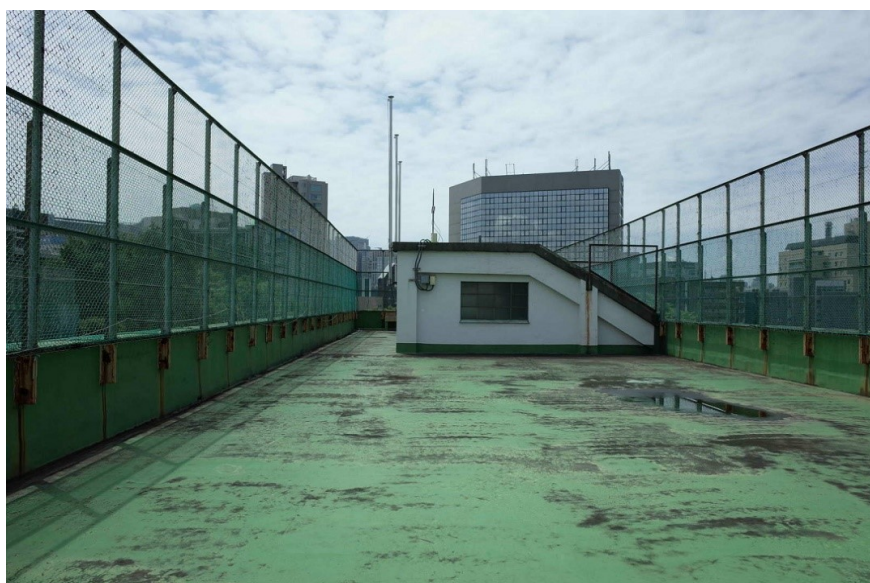
32-01-屋上と西第3階段 ペントハウス
