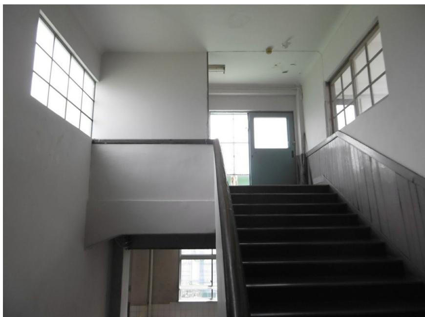
08-06-西第3階段ペントハウス 内部
