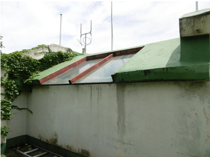
30-05-屋上西棟旧観測所天窗
