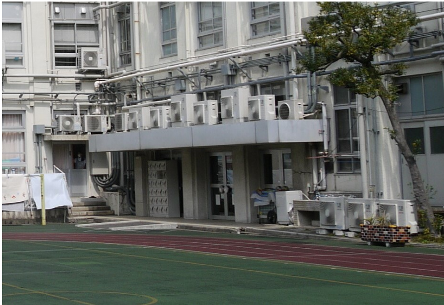
09-04-1F第一昇降口校庭側
