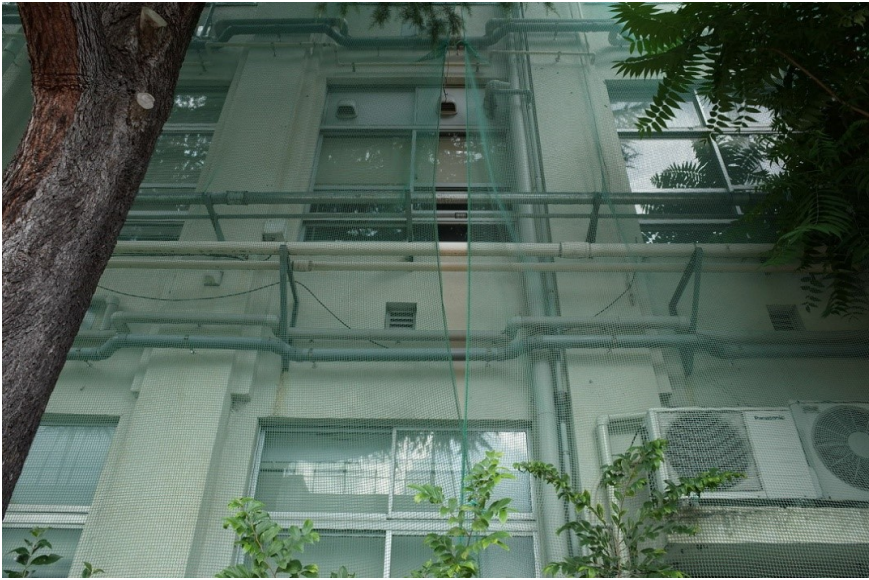
39-01-外観校庭側外壁と 給気ガラリ
