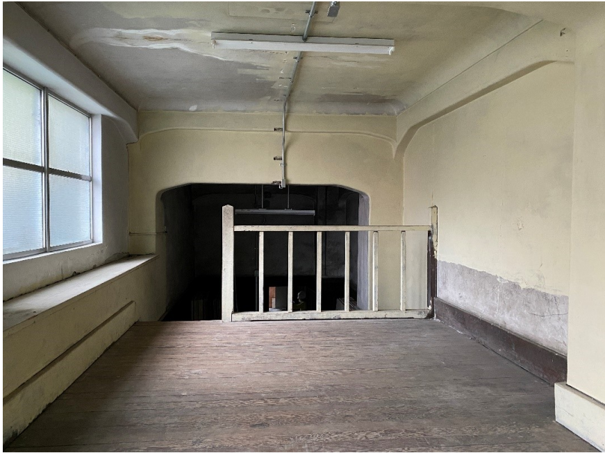
14-03-1F体育館倉庫の2階
