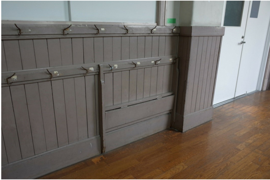
03-05-北棟普通教室前廊下の 腰壁と造作
