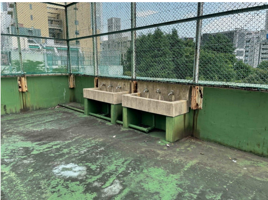
28-01-屋上西棟人研ぎ流し
