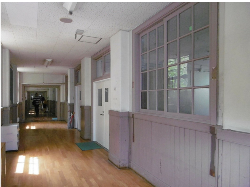
03-01-1F東棟旧衛生室前の廊下
