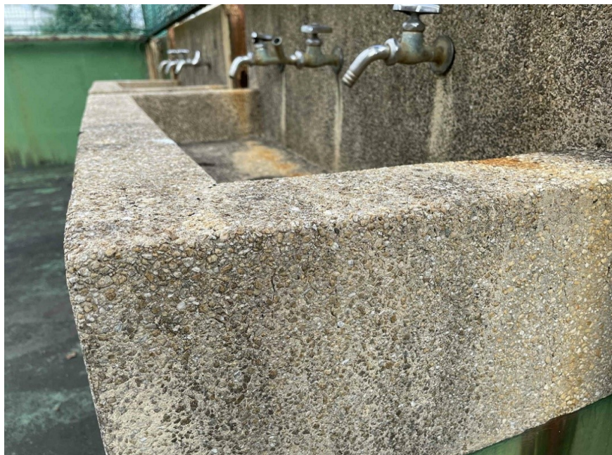
28-02-屋上西棟人研ぎ流し
