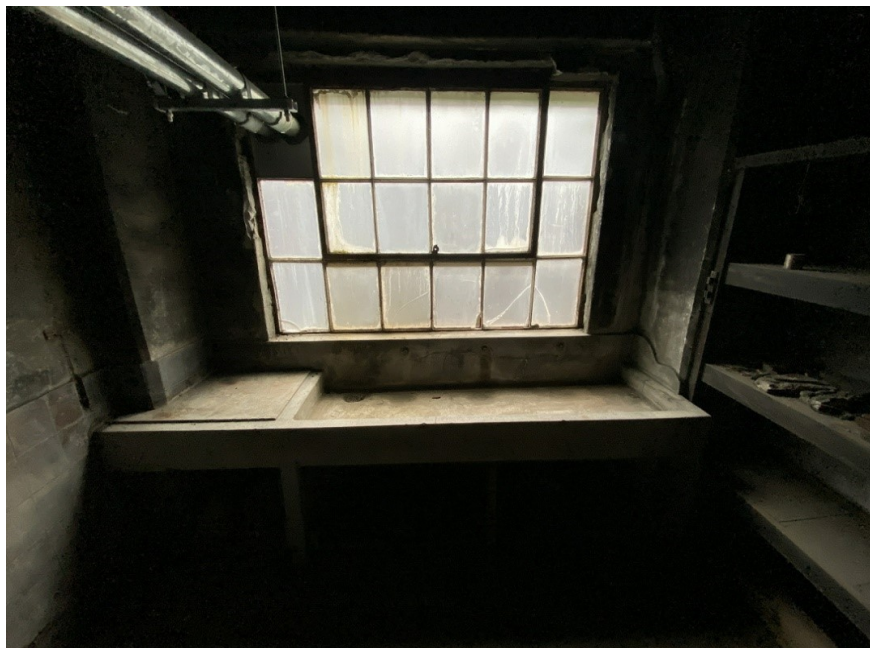
33-02-地階北棟旧湯沸室 スチールサッシ
