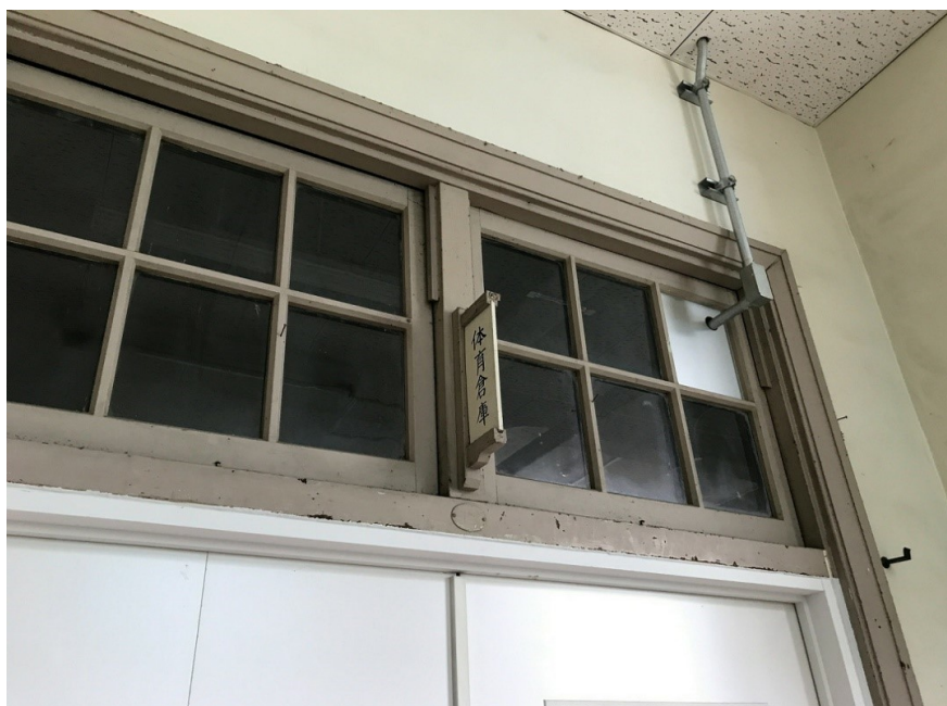
14-01-1F体育館倉庫入口の 欄間と室名札
