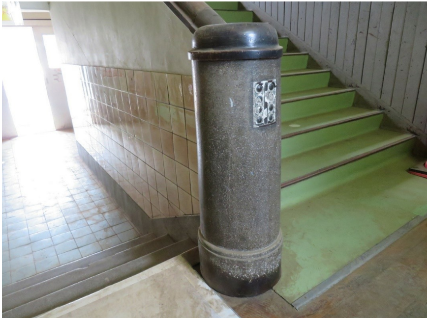
07-01-南東第1階段親柱
