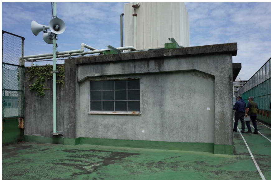
31-01-南東第1階段ペントハウス
