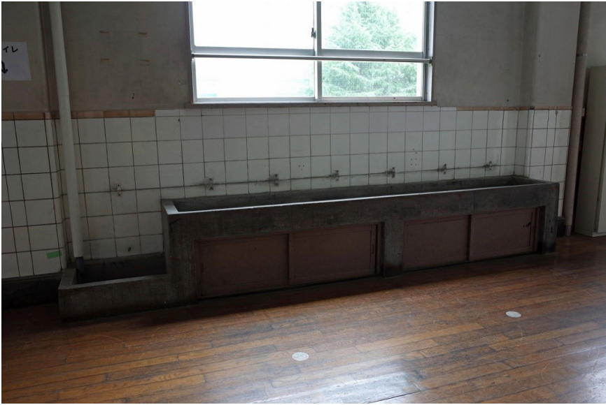
05-05-3F西棟廊下人研ぎ流し
