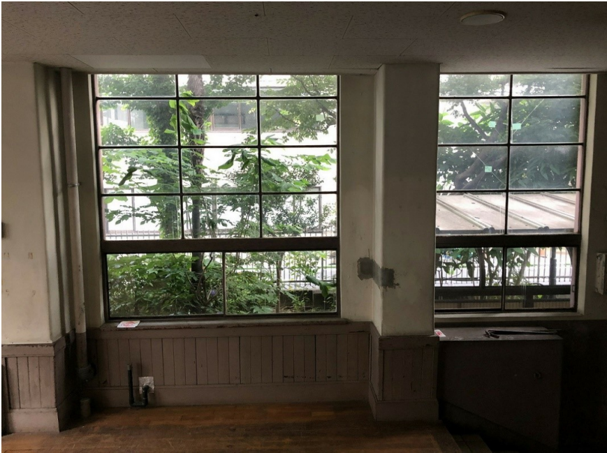
03-02-1F東棟廊下窓造作
