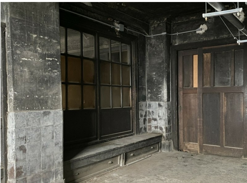
34-02-地階北棟湯沸室から 旧小使室扉
