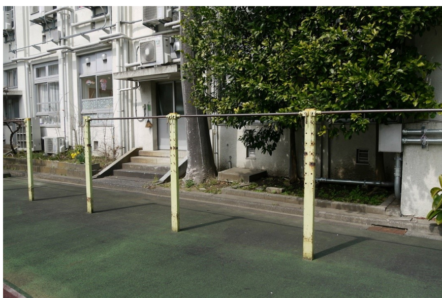
11-02-1F東棟旧衛生室 給気ガラリ外観
