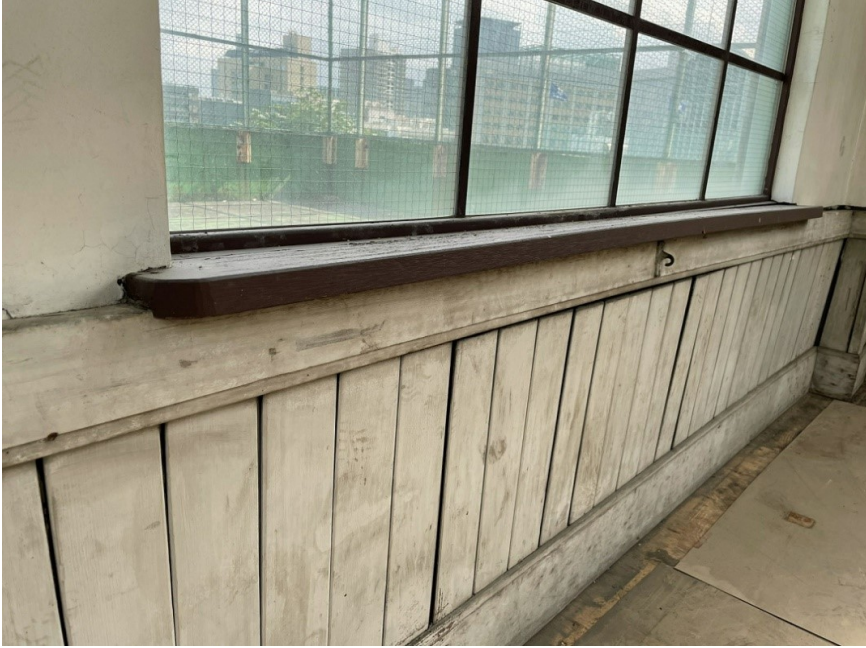
30-03-屋上西棟旧観測所 腰壁と窓台
