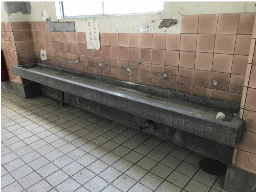
16-02-1F体育館前廊下 腰壁のタイルと人研ぎ流し
