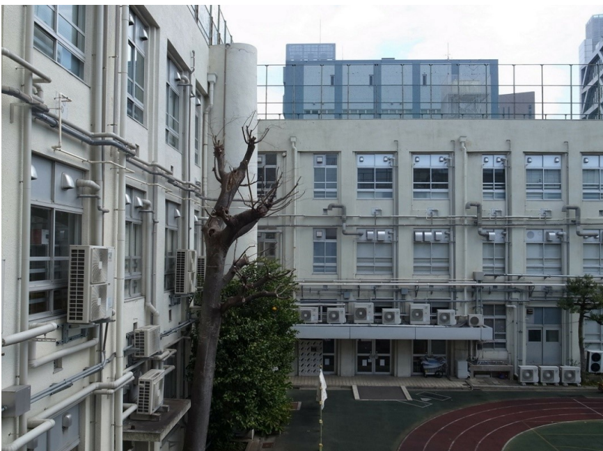
37, 38-02-外観校庭側の外壁面
