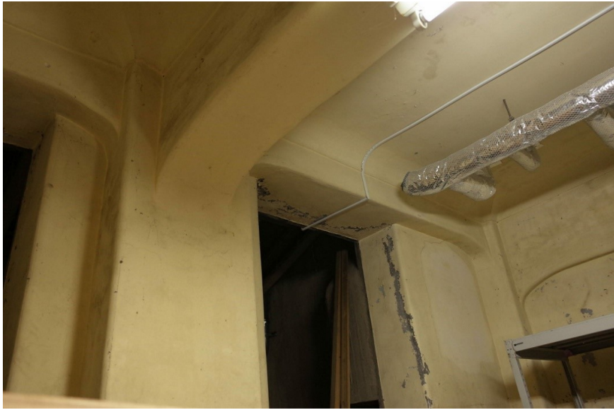
35-01-地階北棟旧ボイラー室 躯体と線形
