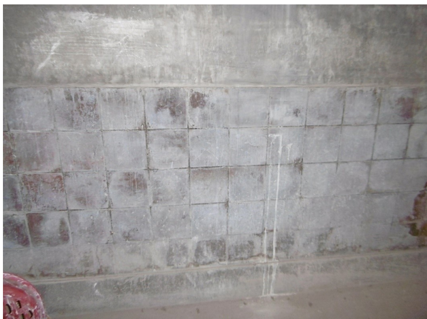
33-04-地階北棟旧湯沸室 腰タイル
