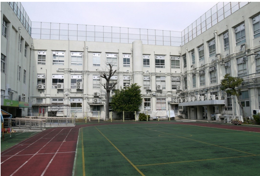
37, 38-01-外観校庭側。煙突跡
