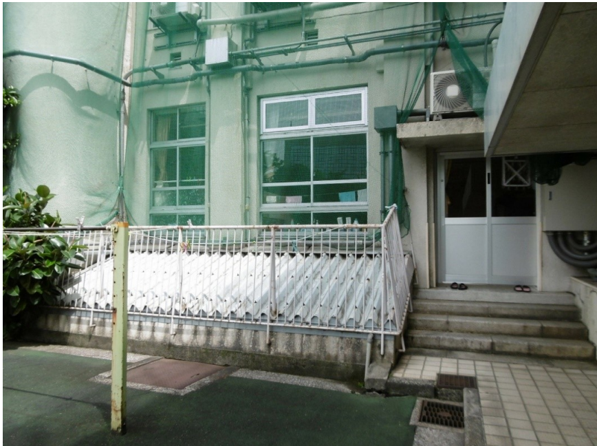
35-02-地階北棟ボイラー室 ドライエリア上部
