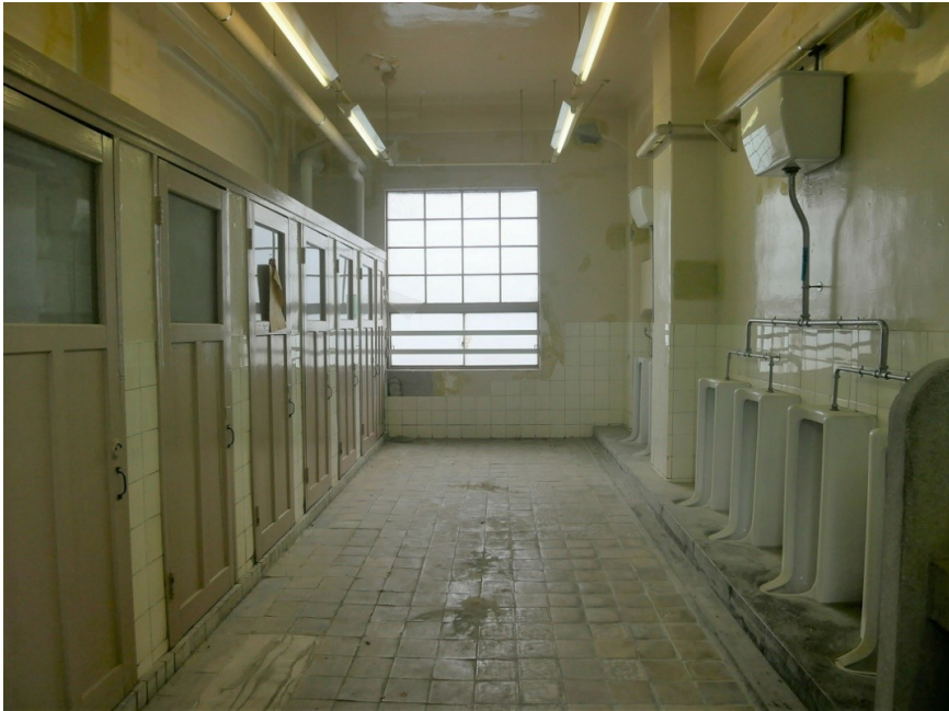
27-01-3F西棟便所
