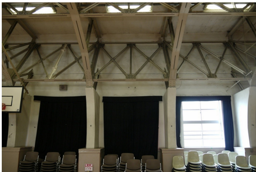
13-04-1F体育館鉄骨梁
