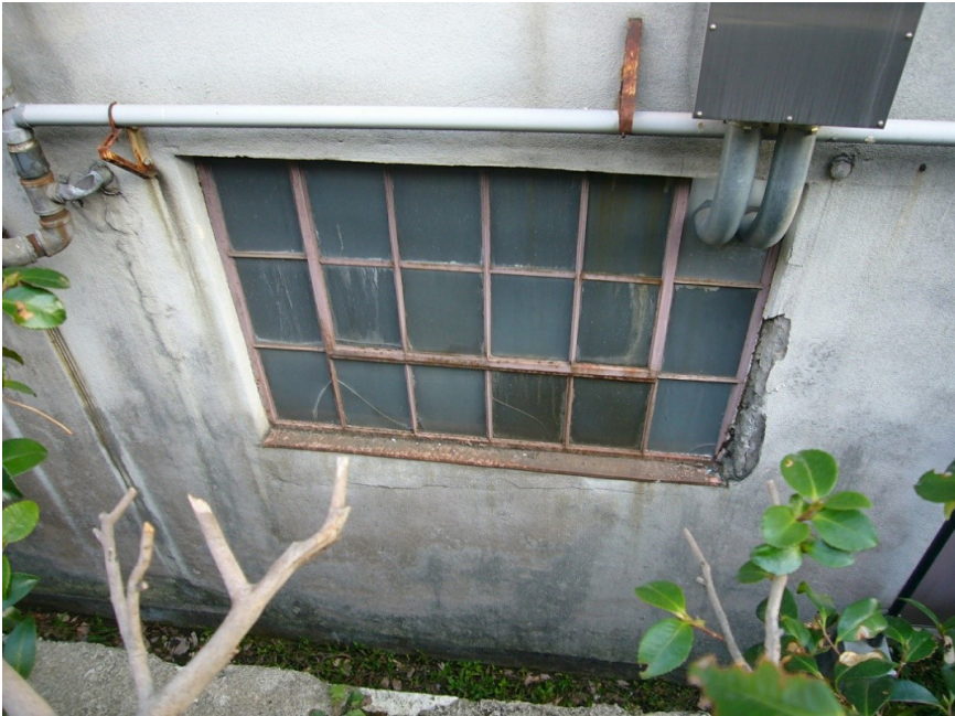
33-05-地階北棟旧湯沸室 スチールサッシ外観
