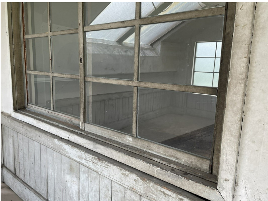
30-02-屋上西棟旧観測所内 窓造作
