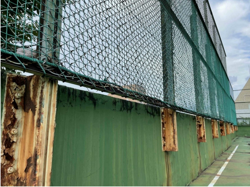
29-02-屋上スチール手すり支柱
