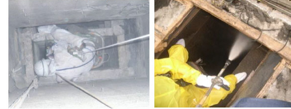
工事従事者の健康被害防止（除染状況）
