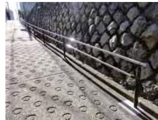
急な坂道への手すりの設置
