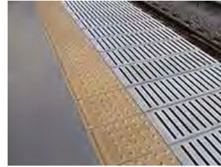
内方線付点状ブロック
