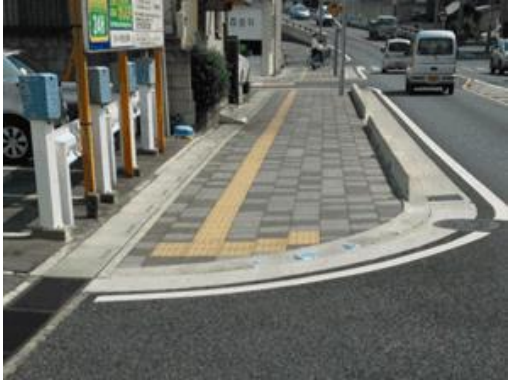
バリアフリー化された歩道
