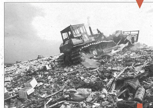
埋立処分場で整地作業をするブルドーザー 昭和63年
