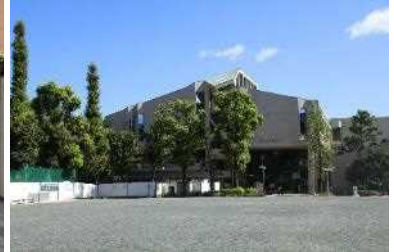
文京スポーツセンター
