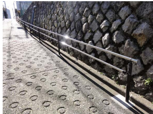
急な坂道への手すりの設置
