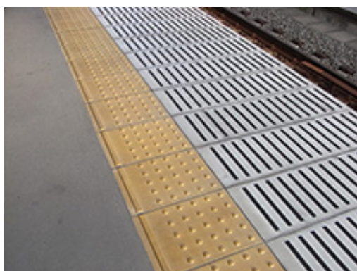
内方線付点状ブロック
