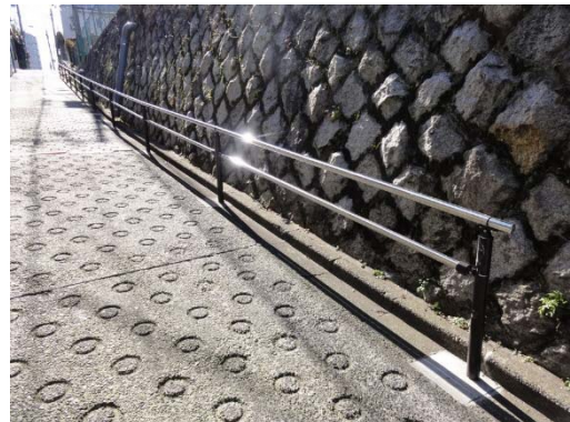
急な坂道への手すりの設置
