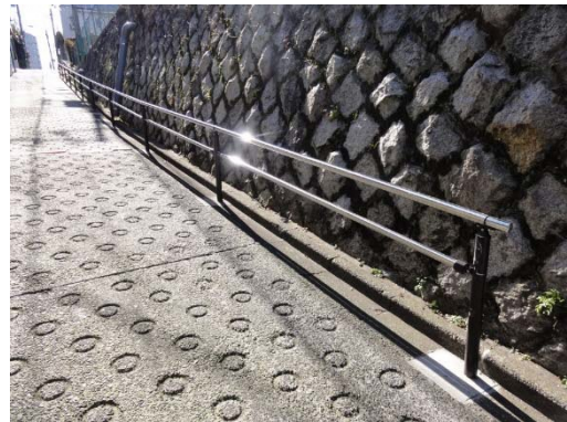
急な坂道への手すりの設置
