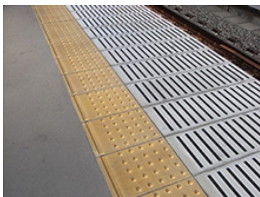
内方線付点状ブロック
