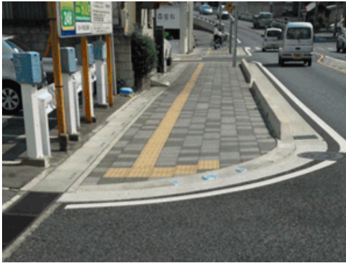
バリアフリー化された歩道
