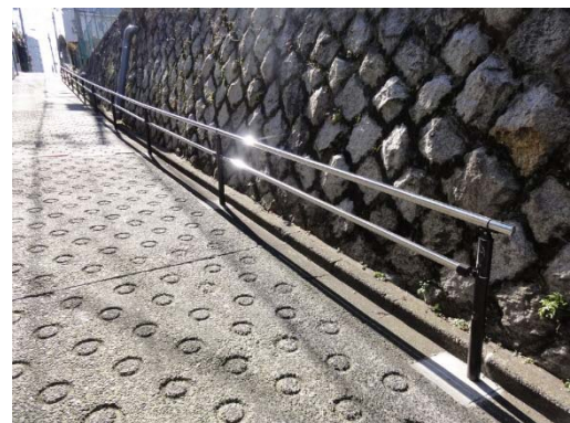
急な坂道への手すりの設置
