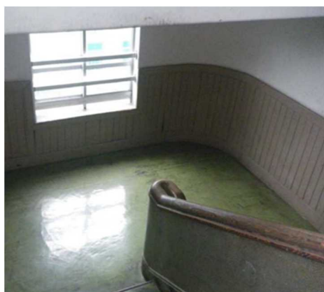
角をとった丸い意匠の階段親柱や階段室
