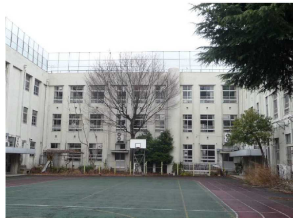
公園（校庭）側から見た北側校舎（内面）
