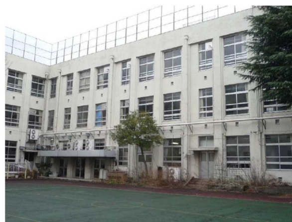
公園（校庭）側から見た東側校舎（内面）
