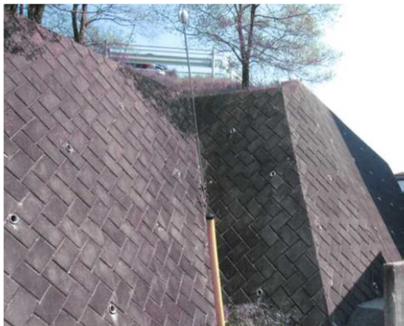
間知石積み擁壁施工例
