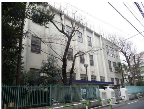
正面玄関側から見た東側校舎（外面）
