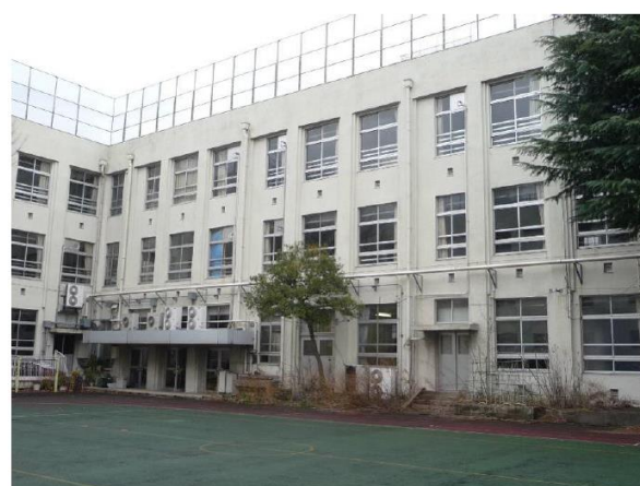
公園（校庭）側から見た東側校舎（内面）
