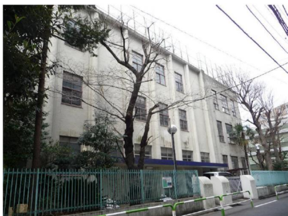
正面玄関側から見た東側校舎（外面）
