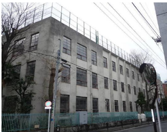
北側前面道路側から見た北側校舎（外面）
