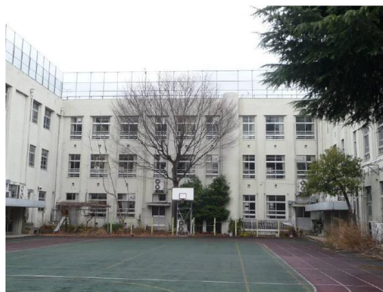
公園（校庭）側から見た北側校舎（内面）
