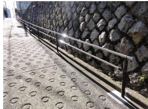
急な坂道への手すりの設置
