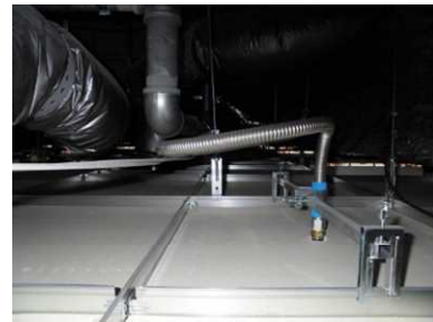
スプリンクラー配管のフレキシブル化
