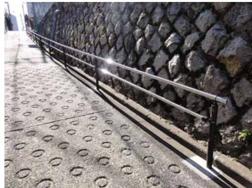
急な坂道への手すりの設置
