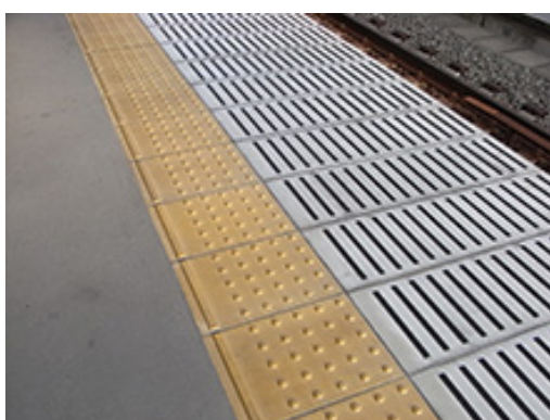
内方線付点状ブロック
