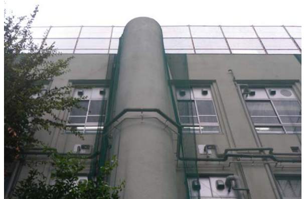
写真-16：旧元町小学校 集中暖房のための煙突跡
