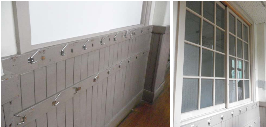
写真-20：旧元町小学校 木製の腰壁や建具
