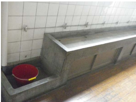
写真-17：旧元町小学校 手洗い場のある廊下
