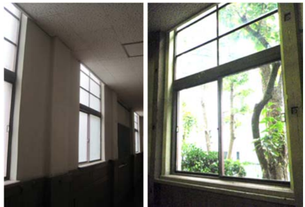
写真-18：旧元町小学校 大きくとられた窓
