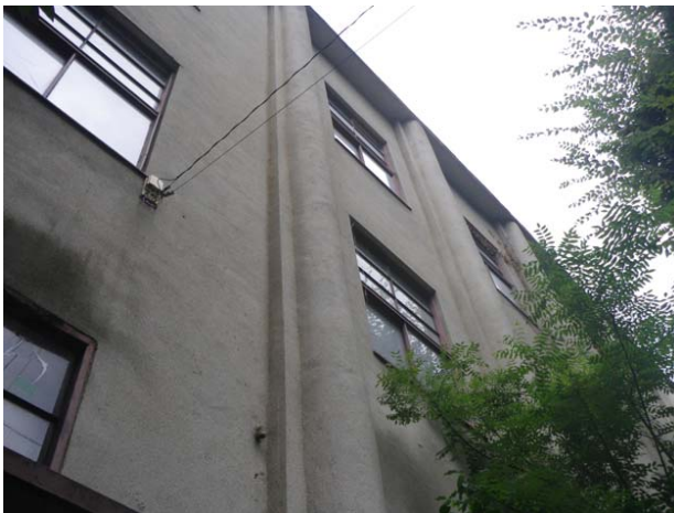
写真-15：旧元町小学校 柱型の外観
