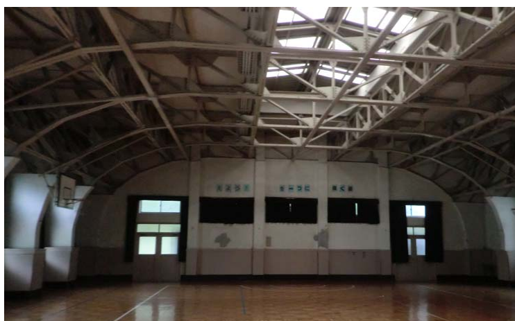
写真-25 : 旧元町小学校 鉄骨造の体育館
