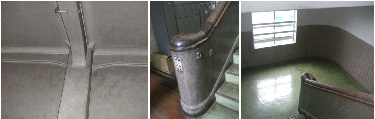
写真-19：旧元町小学校 角をとった丸い意匠（梁・親柱・階段室）
