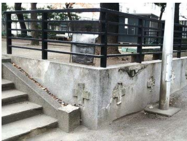
写真-22 : 元町公園 大谷石に施されたモチーフ
