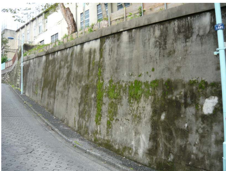
写真-28：元町公園・旧元町小学校 擁壁
