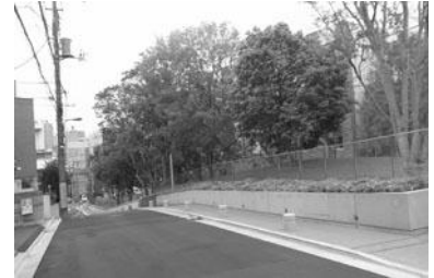
敷地内の緑も見通せる透過性のある塀 (国際仏教学大学院大学 春日)
