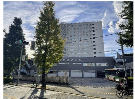
東京都立駒込病院
