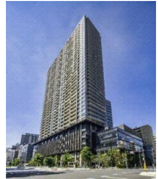
春日・後楽園駅前地区 市街地再開発事業 北街区
