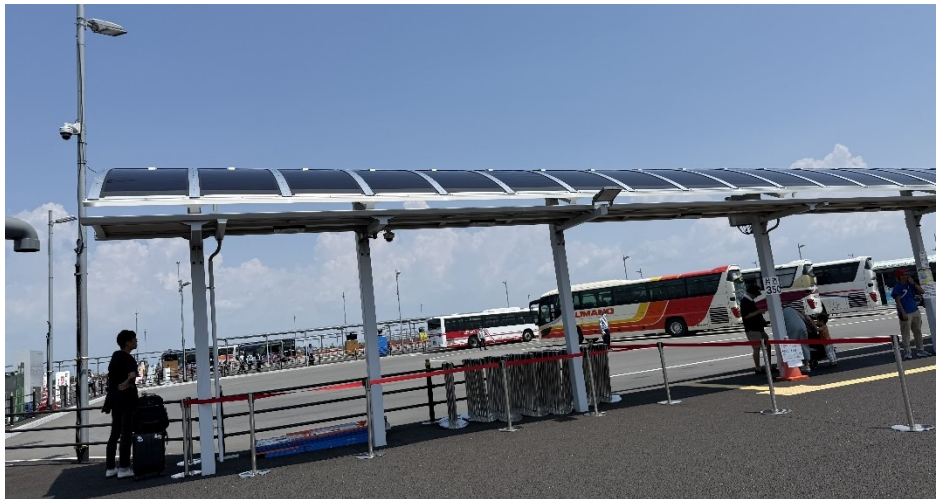
△大阪万博でバスターミナルに設置されていた世界最大級のペロブスカイト太陽電池
