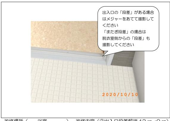
改修場所( 浴室 ) 改修内容(②出入口段差解消 12 cm→O cm) ※工事箇所については、改修した場所が確認できて、改修前と改修後共に同じ方向から撮影したもの
