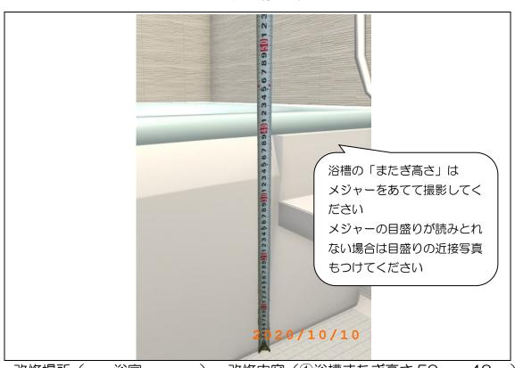
改修場所( 浴室 ) 改修内容(①浴槽またぎ高さ50 cm→42 cm) ※工事箇所については、改修した場所が確認できて、改修前と改修後共に同じ方向から撮影したもの
