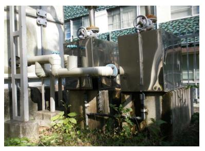
写真番号 9 設備 受水槽 部分 基礎、配管類 判定 1 状況 基礎・配管類に異常無
