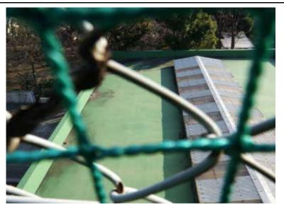
写真番号 34 位置 屋上 部分 防水 判定 状況 体育館屋根:ウレタン塗膜防 水のトップコートの劣化有
