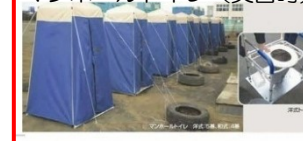
防災マンホールトイレ
