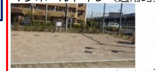
マンホールトイレ(災害時)
