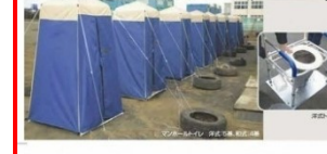
防災マンホールトイレ
