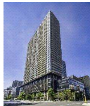
春日・後楽園駅前地区市街地再開発事業*北街区
