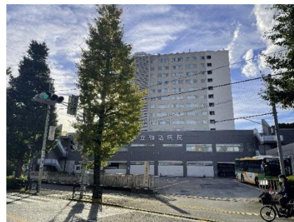
東京都立駒込病院
