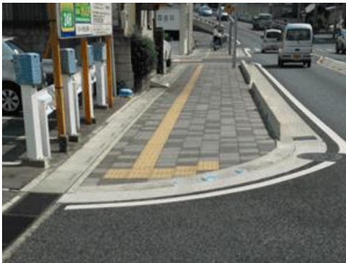
バリアフリー化された歩道
