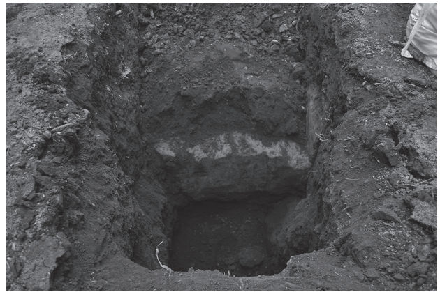
写真 14 試掘坑 2 地下室南側壁面確認状況 (北から)
