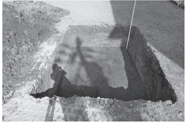
写真2 試掘坑完掘状況（南西から）
