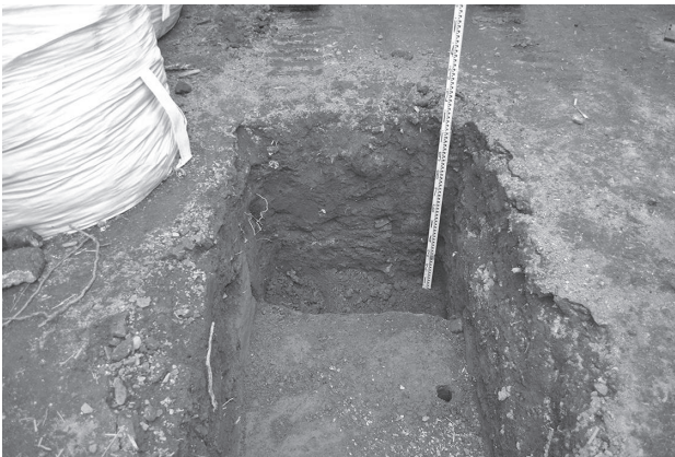
写真 11 試掘坑 2 地下室掘削状況 (南から)
