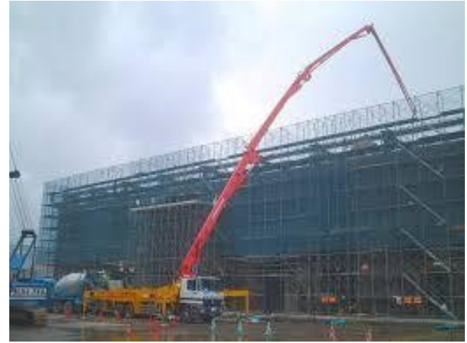
コンクリート打設イメージ
