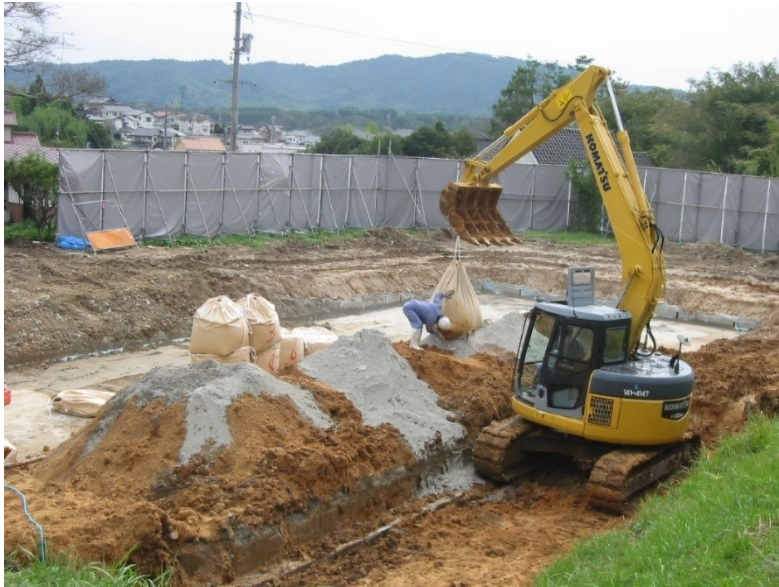
地盤改良工事イメージ
