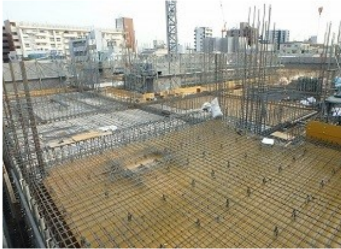
地上躯体工事イメージ
