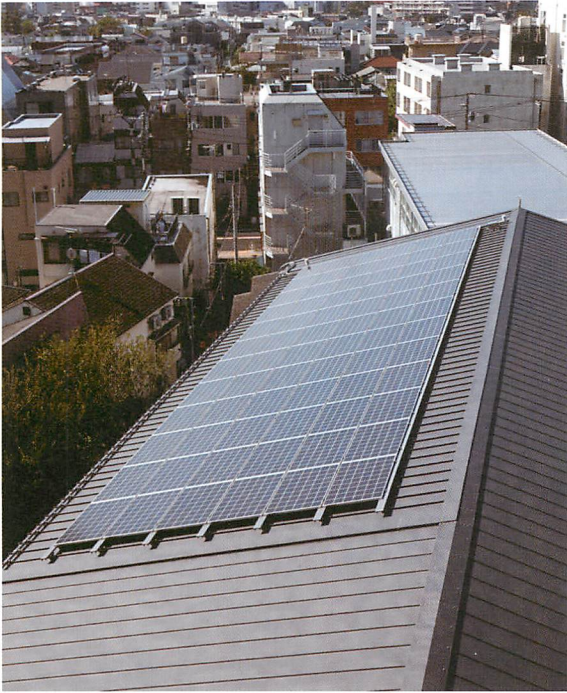
①太陽光発電パネル 体育館の南側屋根に 15kw の発電量を持つ太陽光発電パネルを設置しています。
