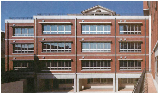
② 教室棟外観 教室棟は南側に開口部を設け、明るく開放的な教室づくりを行っています。
