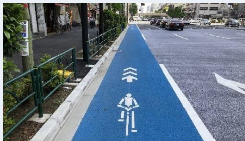
自転車専用通行帯（白山通り）
