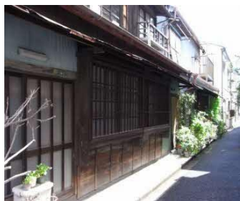
路地沿いに建つ木造の長屋 (根津)
