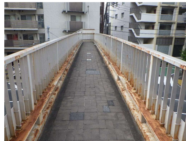
塗膜除去工事前（令和6年度）
