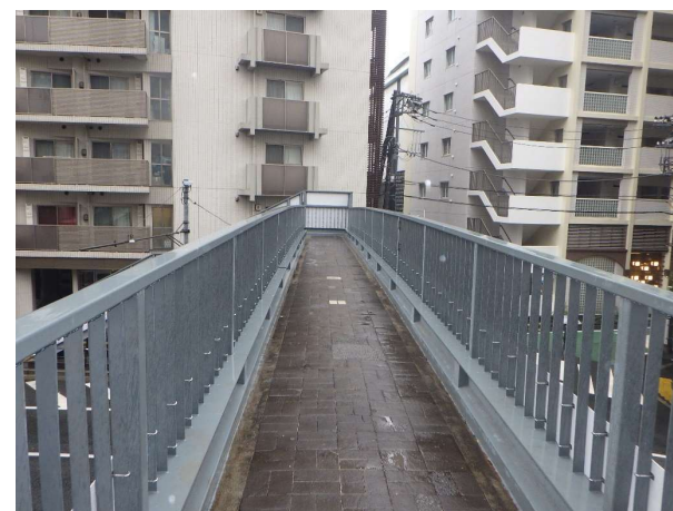
塗膜除去工事後（令和7年度）
