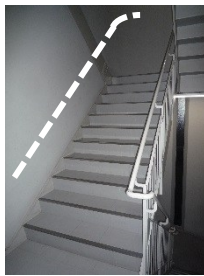
B) 避難階段手すり未設置部・ドアノブ
