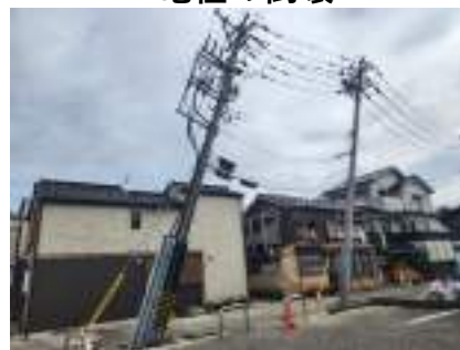
電柱の倒壊
