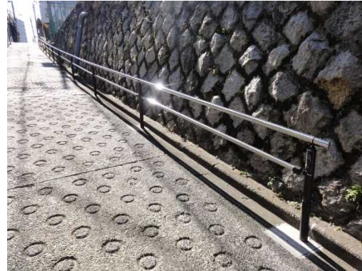
急な坂道への手すりの設置
