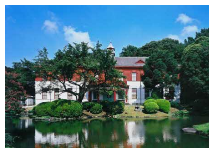
旧東京医学校本館（東京大学 HP）
