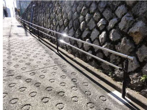
急な坂道への手すりの設置
