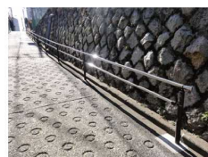
急な手すりへの 手すりの設置
