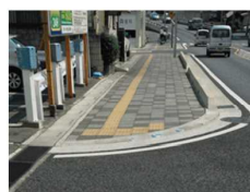
バリアフリー化 された歩道
