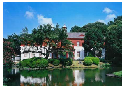
旧東京医学校本館（東京大学 HP）
