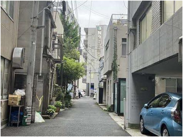
＜狭隘な私道沿いの建物＞
