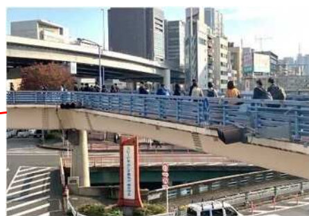
飯田橋歩道橋
